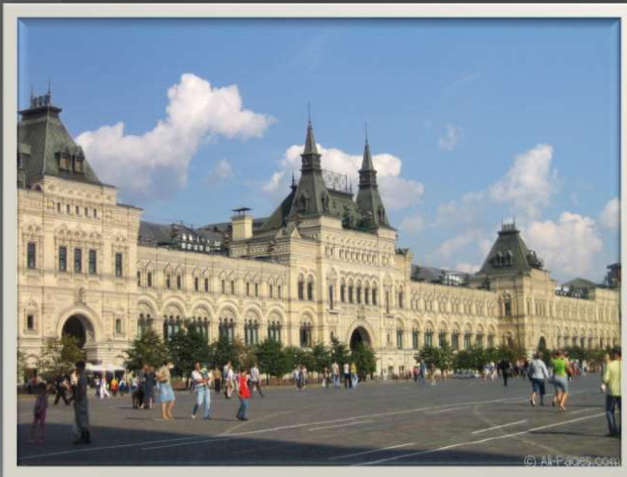
Верхние Торговые ряды в Москве. Архитектор А.Н.Померанцев
